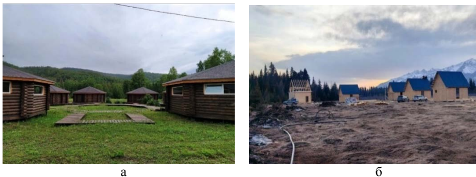
Рис. 2. Строительство новых объектов: а — Визитный центр «Хэшэгтэ», б — гостевые дома в ДНТ «Баян Тала» (март — апрель 2023 г.)
